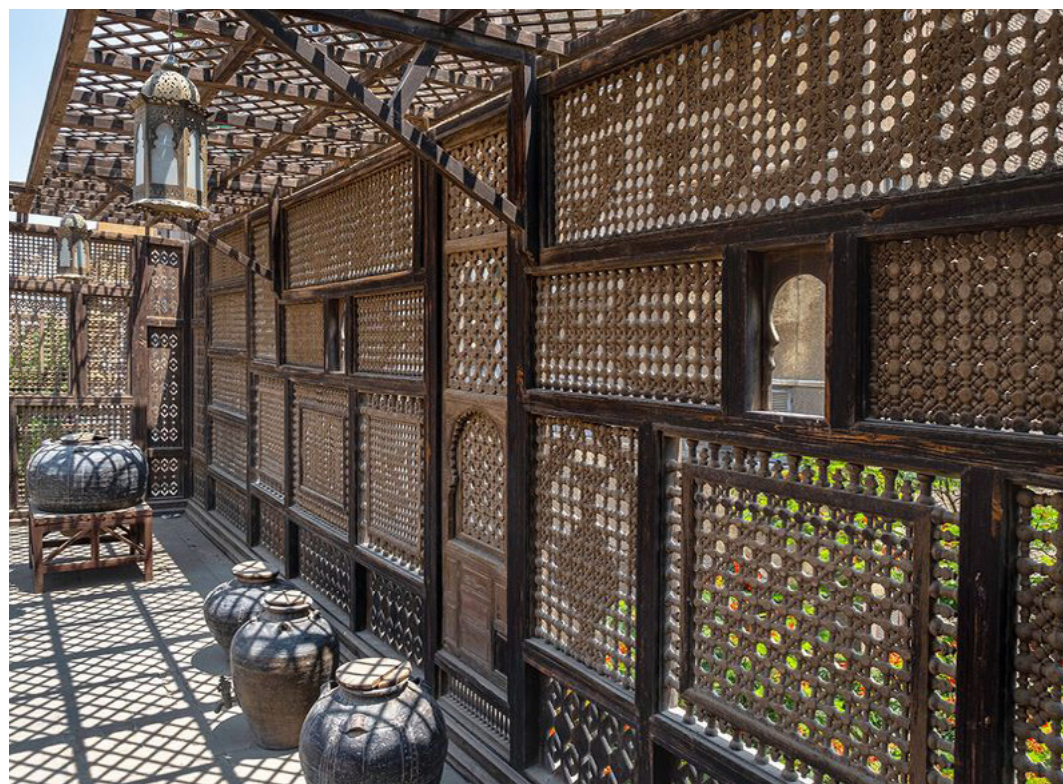
La mashrabiya architecture ha la funzione di raffrescare l'ambiente interno grazie alla riduzione di sezione degli spazi attraversati dall'aria che, per effetto fluidodinamico, aumenta la velocità
