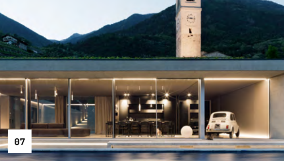
Premio speciale comune di Vicenza / Azienda Pubbliservizi e Comune di Brunico / Studio C e Z Calderan Zanovello Architetti s.r.l. - s.t.p. / Impianto per Sport su ghiaccio - Intercable Arena / 2021, Brunico, Bolzano, Italia
